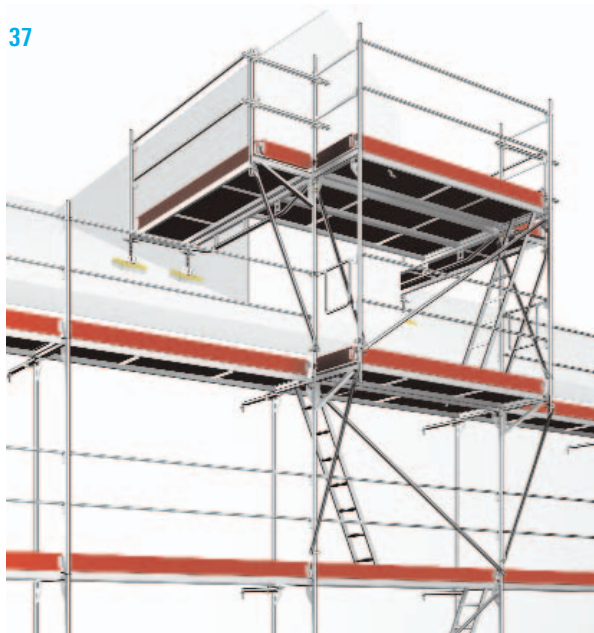
37 Le pareti laterali degli abbaini si ponteggiano senza problemi con i correnti doppi a U in alluminio Blitz. I telai situati oltre l'ultimo piano del ponteggio vanno assicurati con spine di sicurezza.
