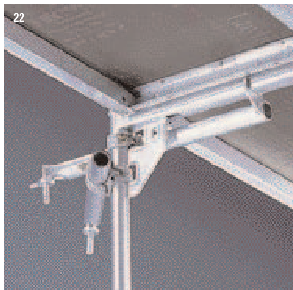
22 Ancoraggio Blitz e tubo di ancoraggio inclinato con giunto ortogonale
